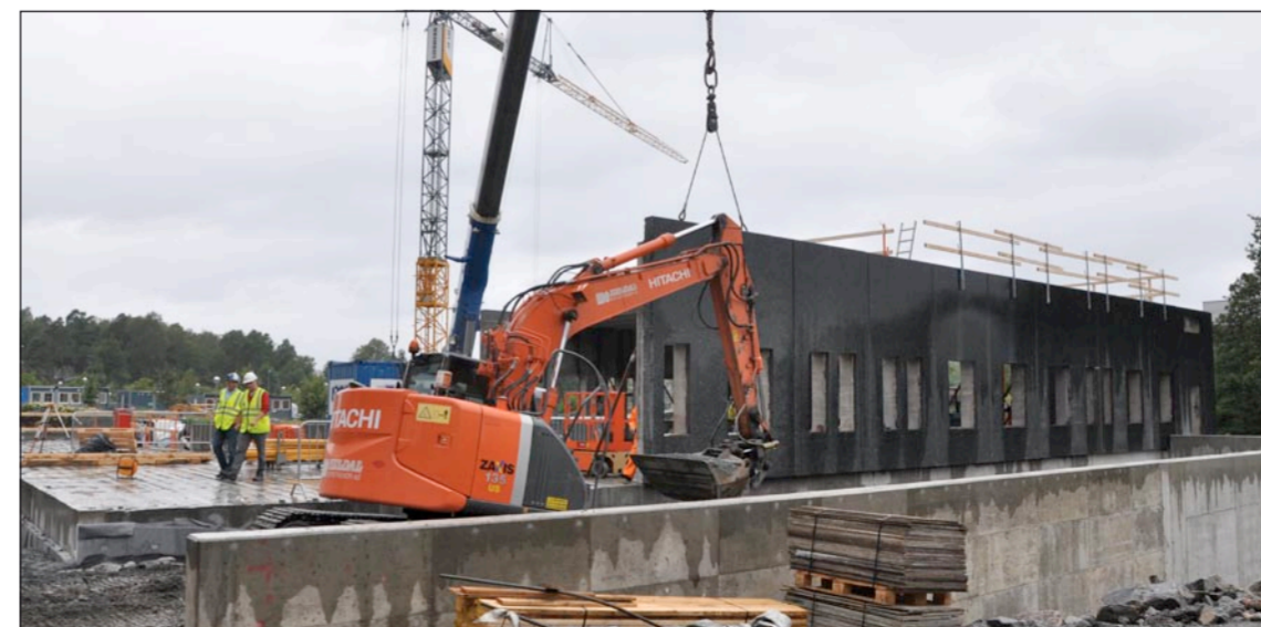
NED. Gravemaskinen er bokstavelig talt på vei ned i kjelleren mens Nilsen og Vedal er ute på omvisningstur med pressen. Her ser vi at veggen til blokk A er i ferd med å reise seg.
